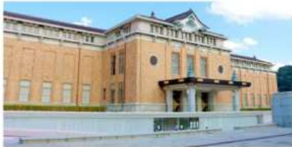
京都・京都モダン建築祭会場11号館
