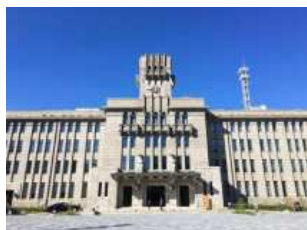
京都市役所本庁舎 3,334人 6日計／中京エリア
