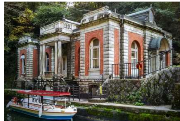
旧御所水道ポンプ室
