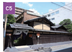
C5 中京 八竹庵(旧川崎家住宅) 入館料割引
